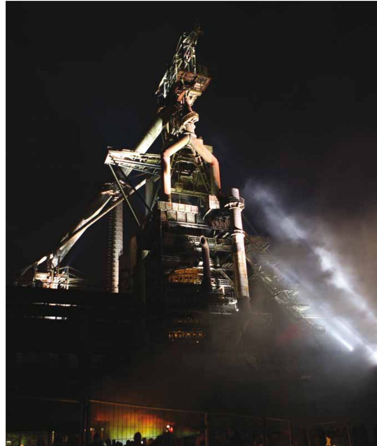
Essai d'illumination nocturne des hauts fourneaux à la lumière blanche. Ces essais, conçus par Ingo Maurer et son équipe, se sont déroulés en octobre 2008.
