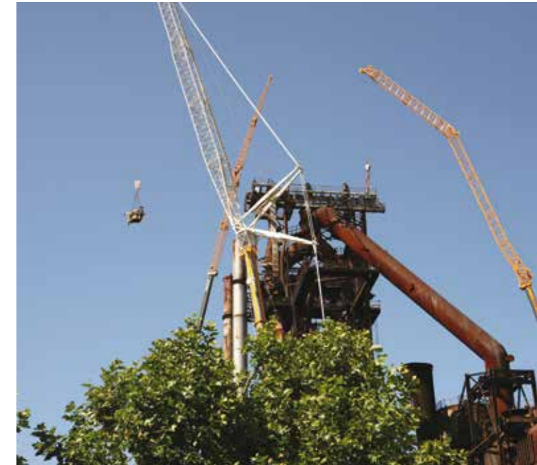
La couronne du Haut Fourneau B en voie de démontage en 2008. .
