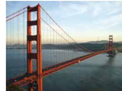
Golden Gate Bridge à San Francisco
