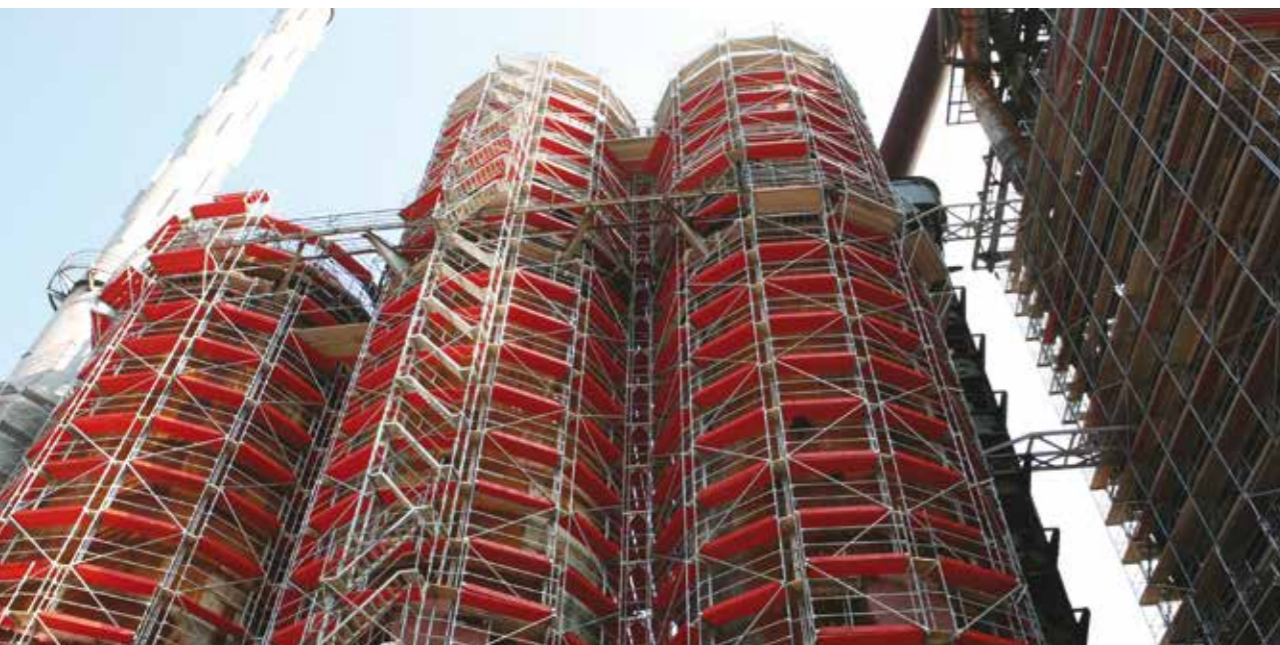
Mise en place des échafaudages sur cowpers du haut fourneau B en 2011
