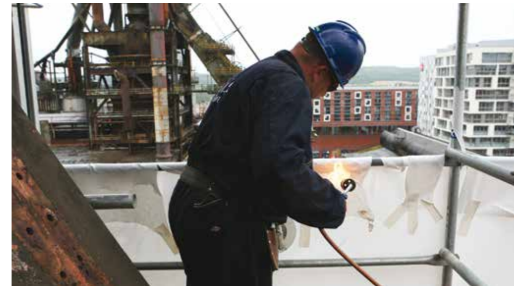
Soudure de bâche thermorétractable
