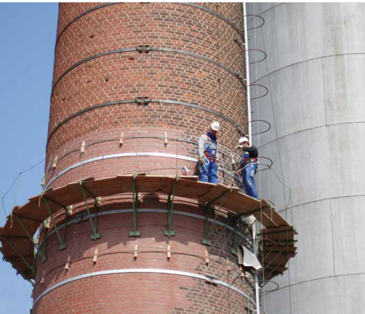
Restauration de la cheminée du haut fourneau A en 2009
