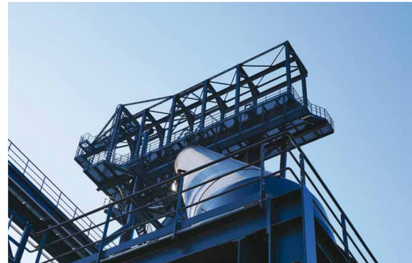
Nouvelle charpente du bleeders du Haut Fourneau B
