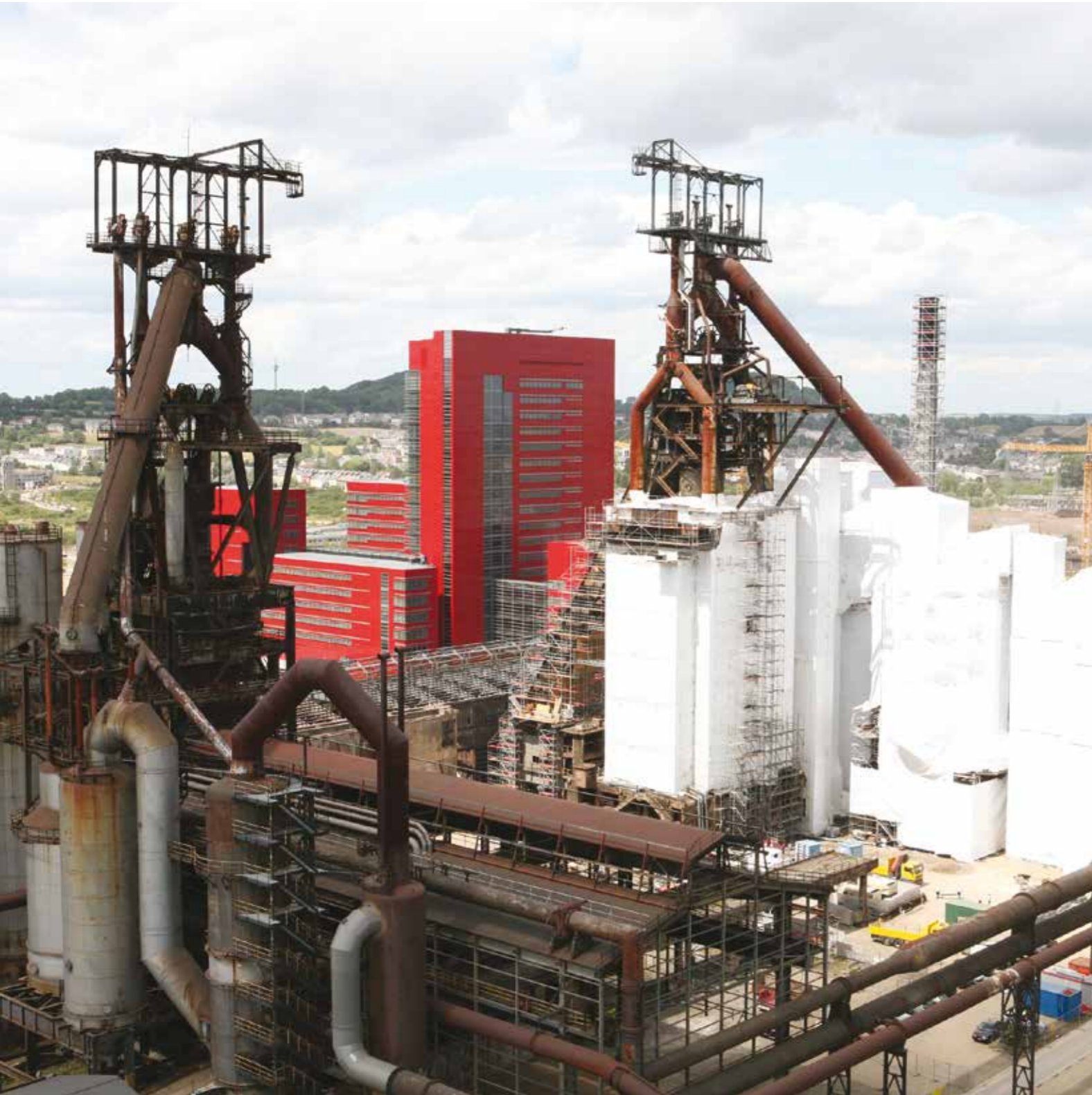
Bâchage du Haut Fourneau B en 2011
