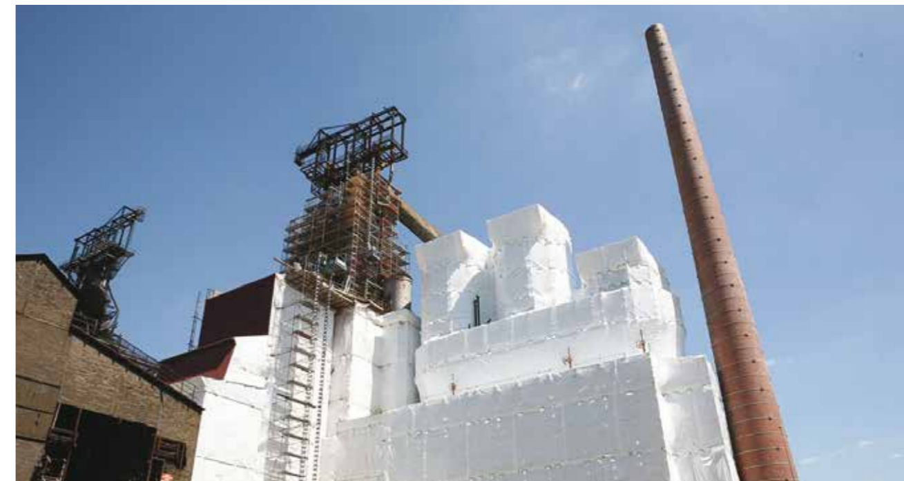
Mise en place du bâchage sur cowpers du haut fourneau A en 2013
