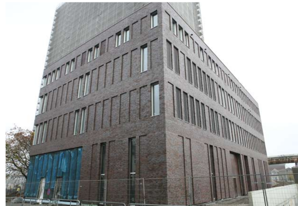
La façade achevée sur une partie du socle
