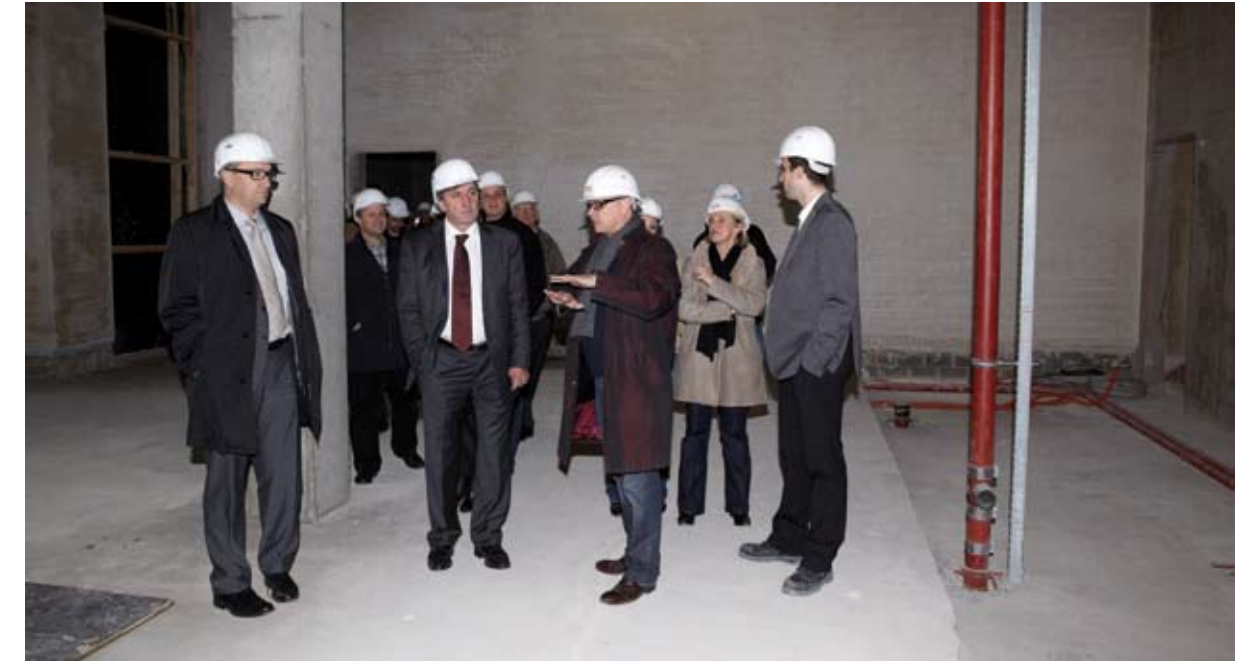
Visite guidée du chantier
