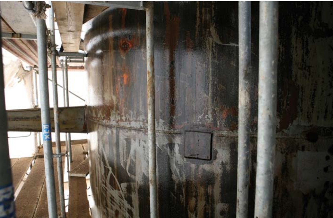
Le traitement avec un vernis fait apparaître les nuances de la patine sur les vestiges industriels
