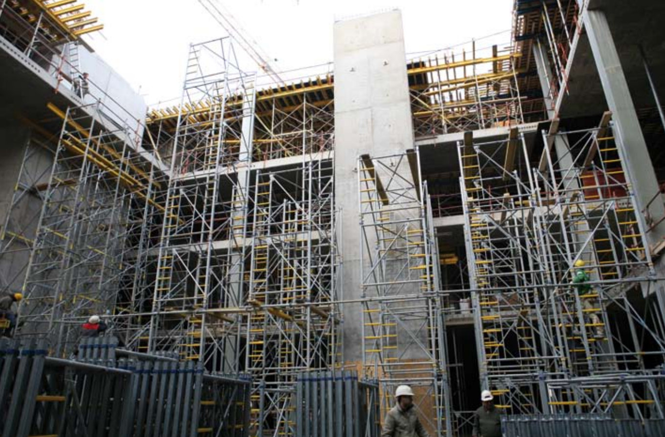
Chantier de la Maison des Sciences Humaines faisant partie de la typologie des bâtiments de bureaux
