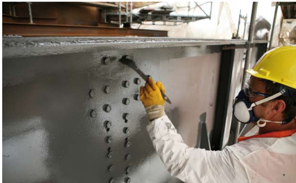
Mise en peinture d'une poutre en teinte grise suivant le concept couleur développé par Ingo Maurer
