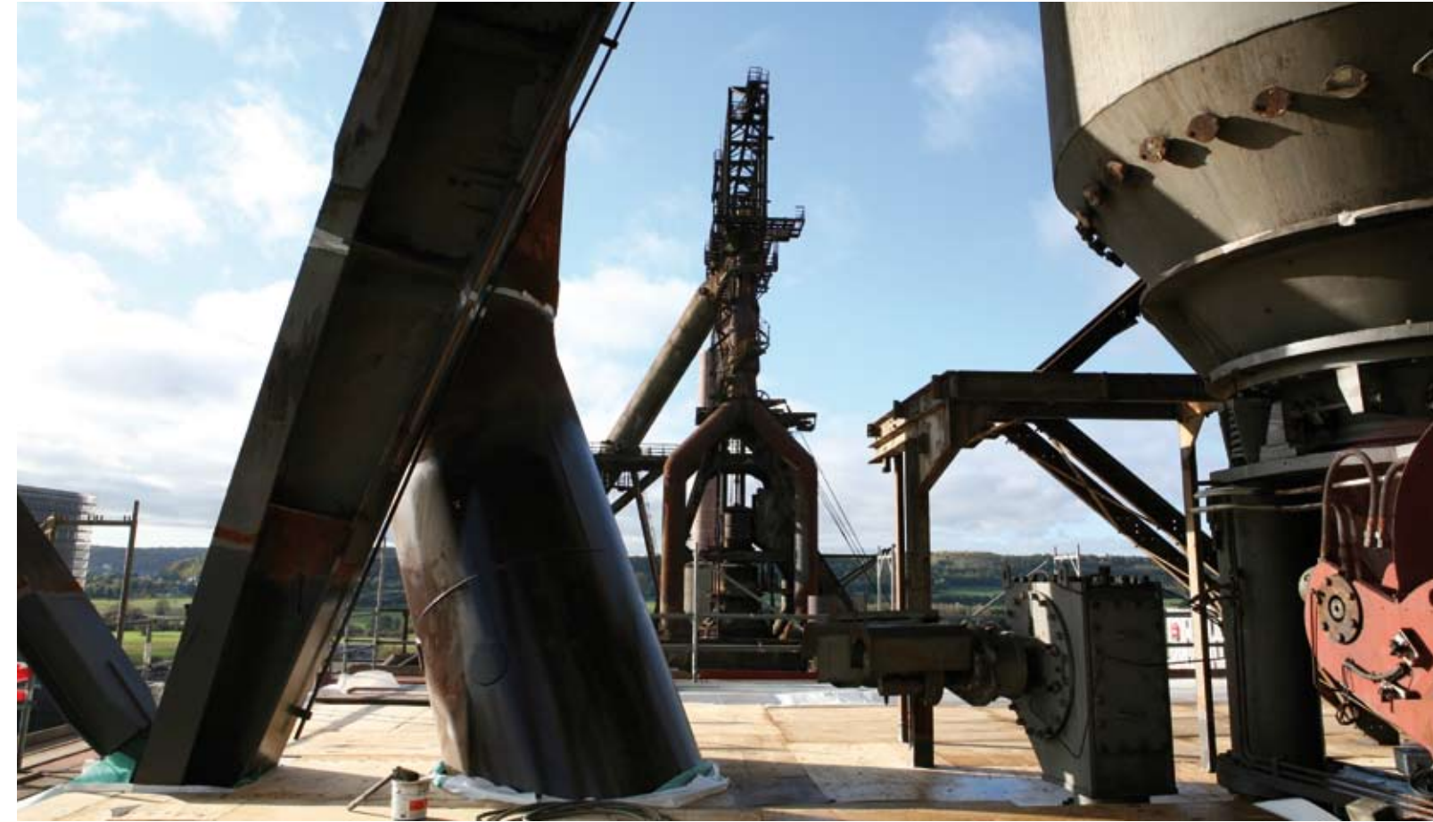
Protection du plancher gueulard pendant la phase de traitement de surface
