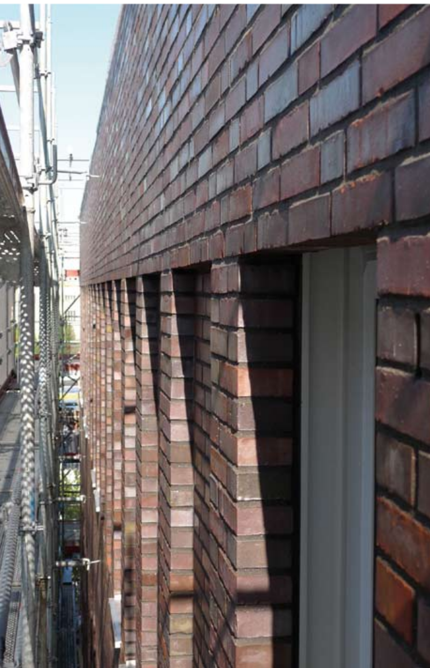
La façade en «klinker» du bâtiment administratif
