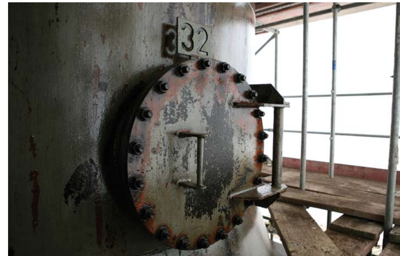
Un trou d'homme après nettoyage et application d'un vernis
