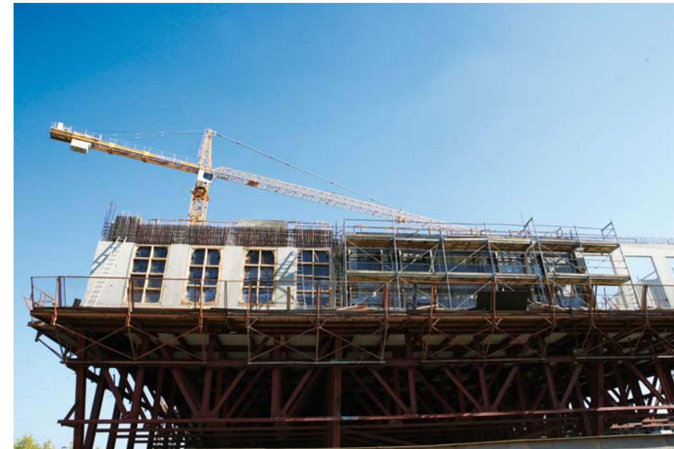
Chantier de la Maison du Savoir faisant partie de la typologie des bâtiments spéciaux
