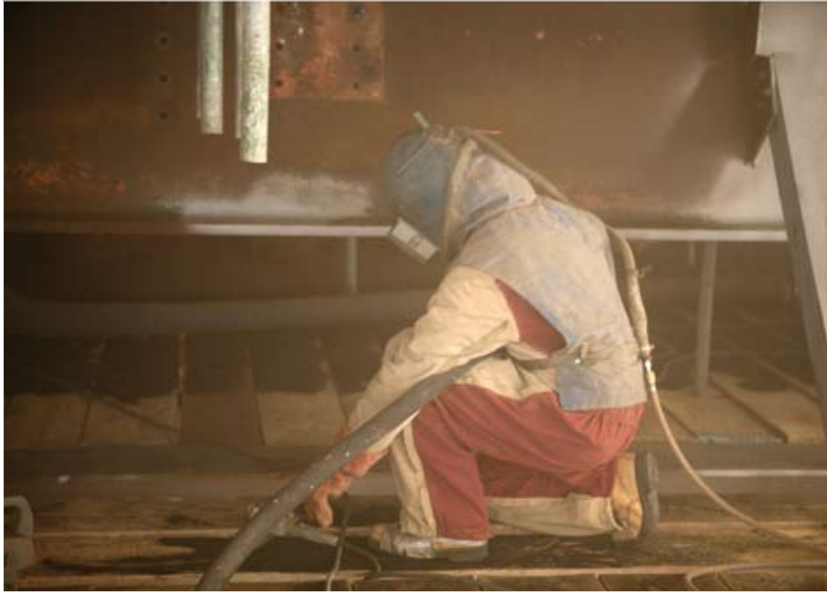
Opération de sablage sur la tour carrée du haut fourneau B
