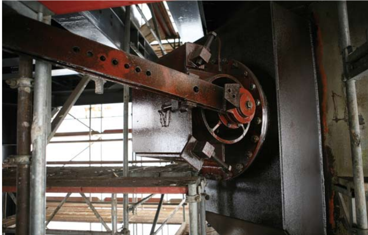
Équipement du laveur après nettoyage et application d'un vernis
