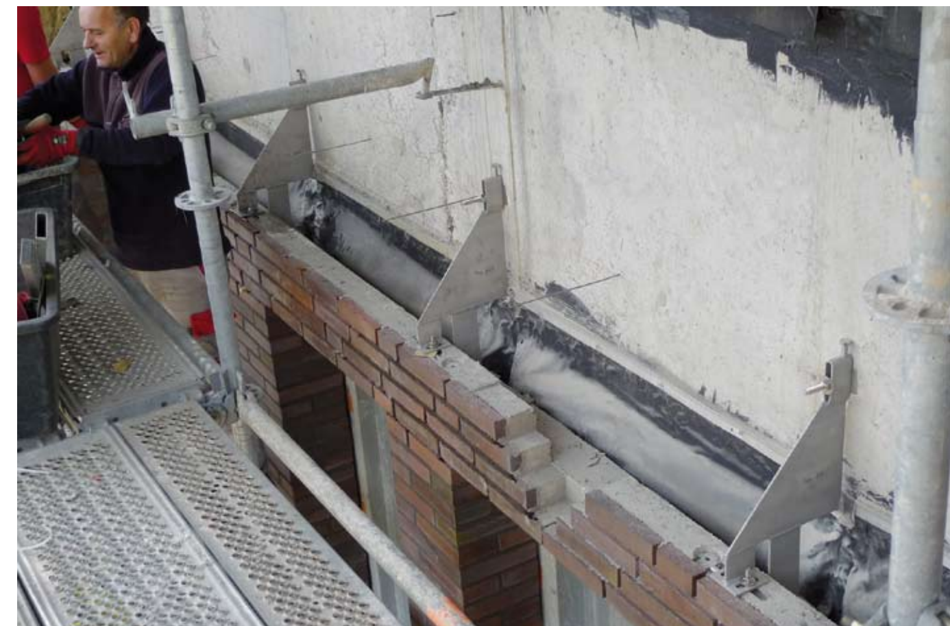
Une couche d'isolation en laine de roche est intégrée entre l'enveloppe en «klinker» et le béton
