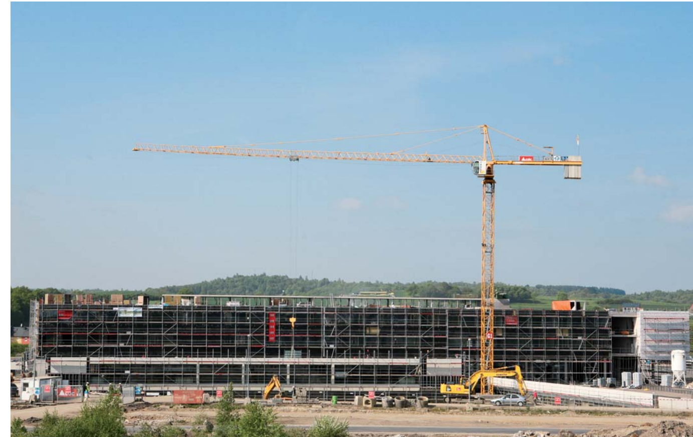
La façade Est du Lycée Belval
