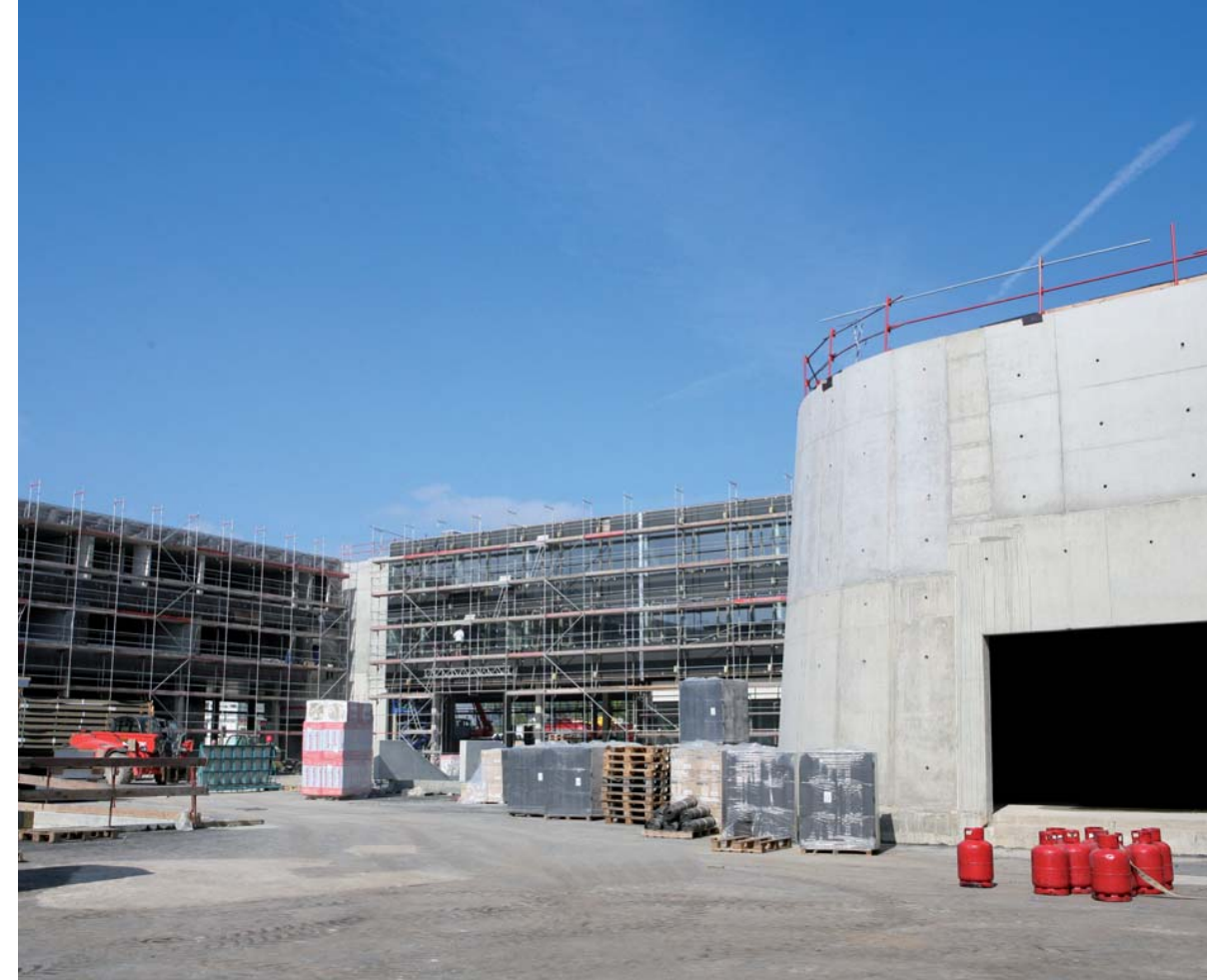
Vue sur la grande cour avec le volume qui abritera la salle des fêtes
