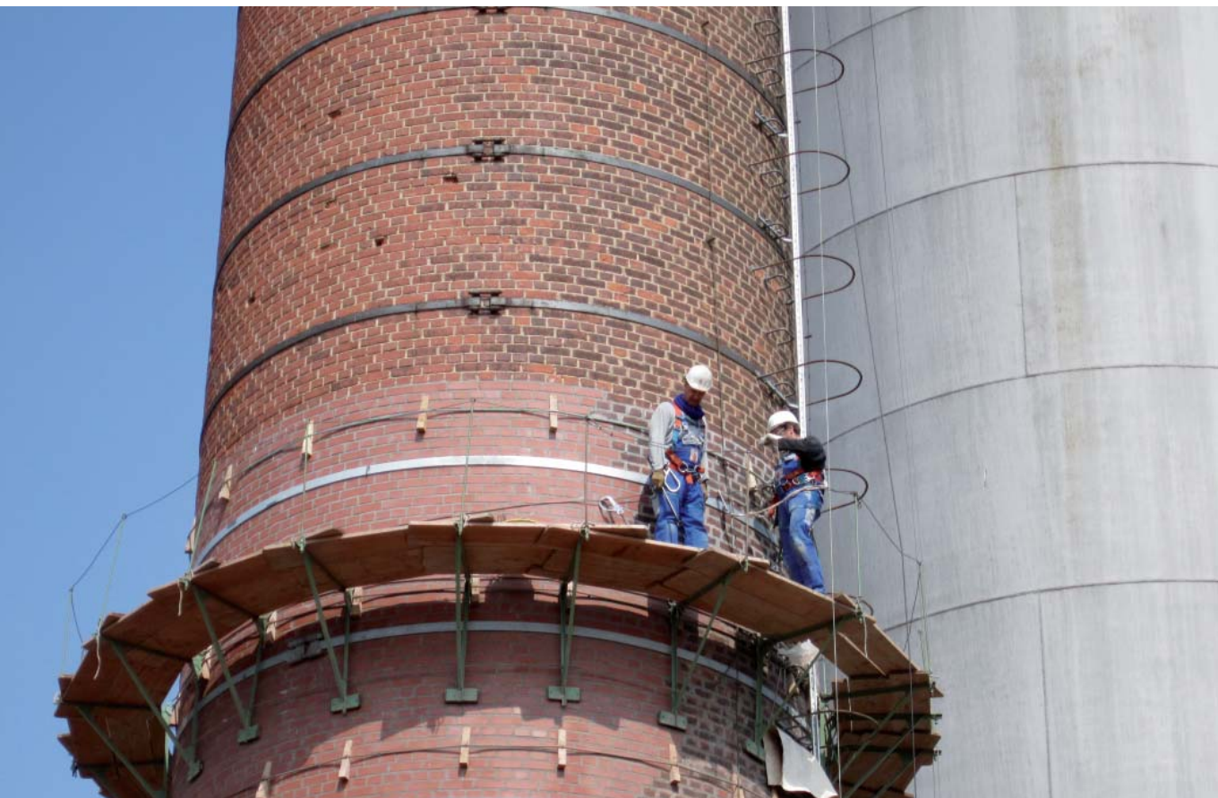
Travaux de restauration de la cheminée
