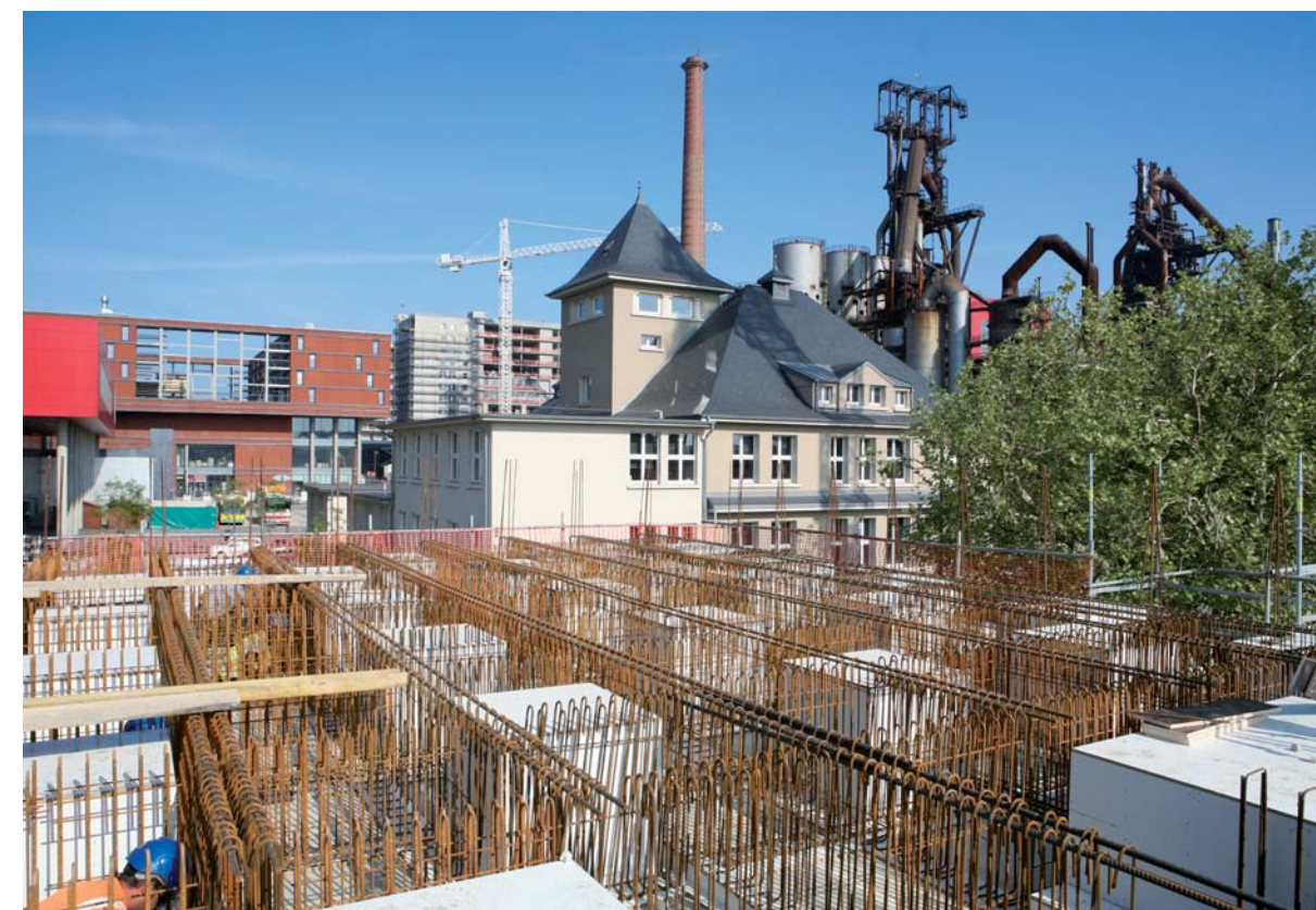
Le Bâtiment administratif en construction face au siège de la société agora, à la Rockhal et aux hauts fourneaux
