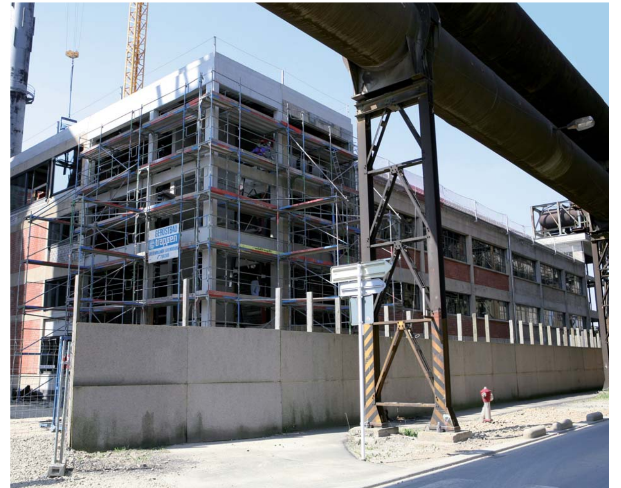
La façade Sud-Est de l'ancien vestiaire transformé en Incubateur d'entreprises
