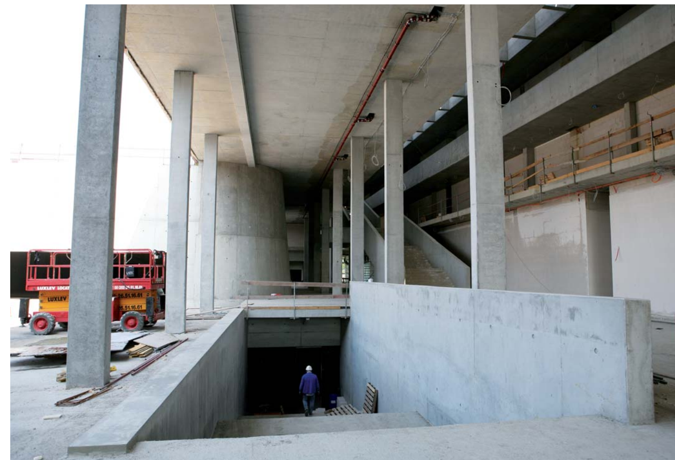
Escaliers vers le rez-de-jardin
