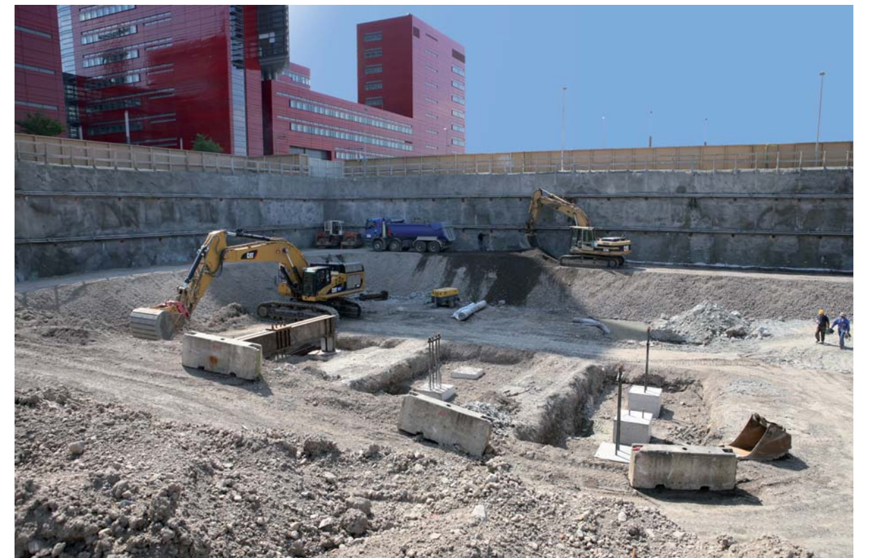
Le futur emplacement de la Maison du Nombre
