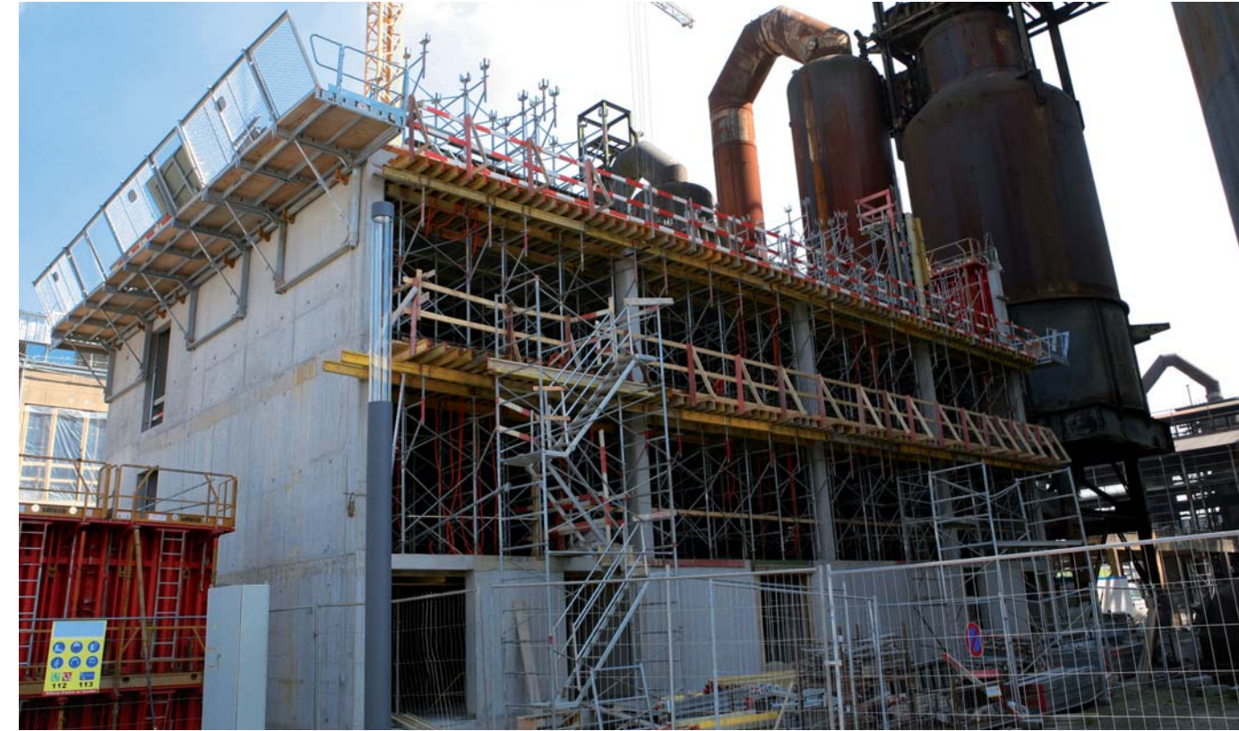
Les premiers niveaux du bâtiment Biotech en construction
