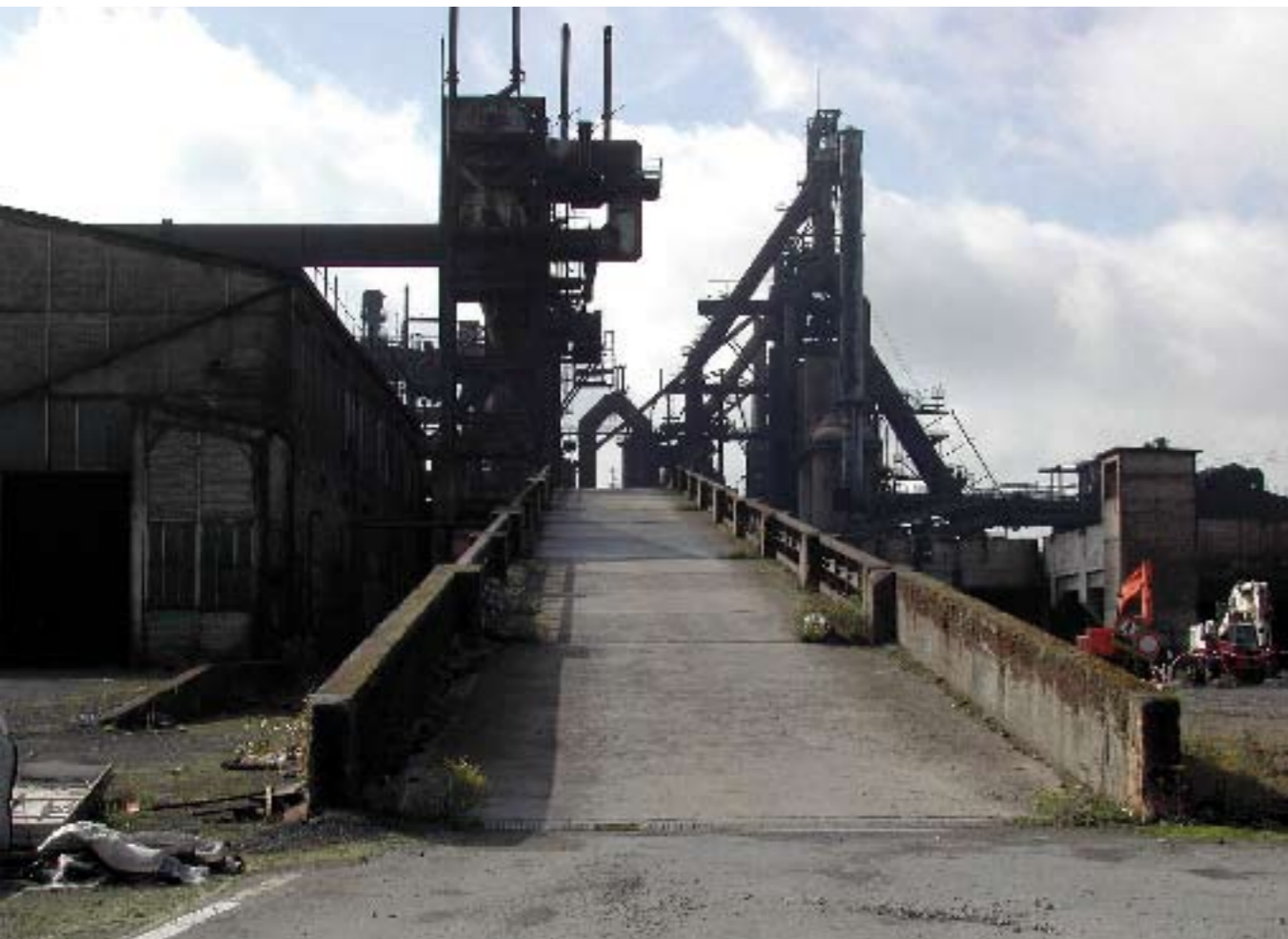
les vestiges de la terrasse tels qu'ils subsistaient en 2001
