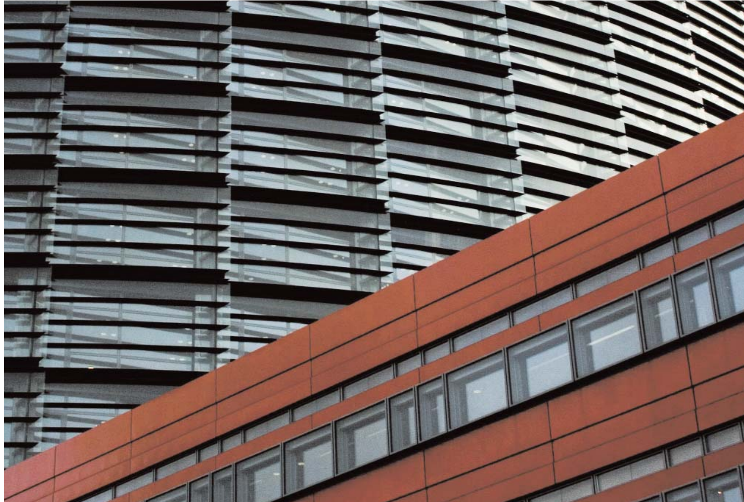
Le bâtiment de la Dexia est d'ores et déjà devenu le signal du renouveau de Belval. Sa tour d'une hauteur de 76 mètres est devenue un Landmark au même titre que les cheminées de l'agglomération et les deux hauts fourneaux qui sont les témoins du passé industriel du site.
