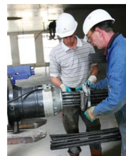
Mise en place des câbles servant à suspendre la barre
