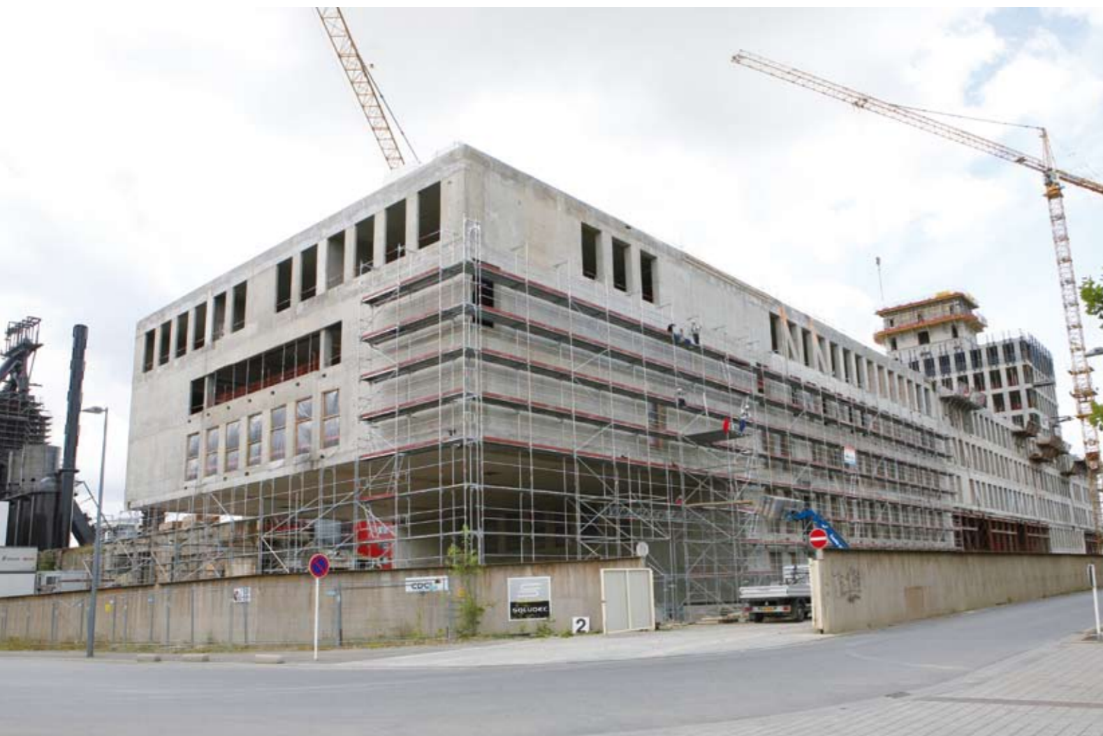
Etat d'avancement de la Maison du Savoir en août 2012
