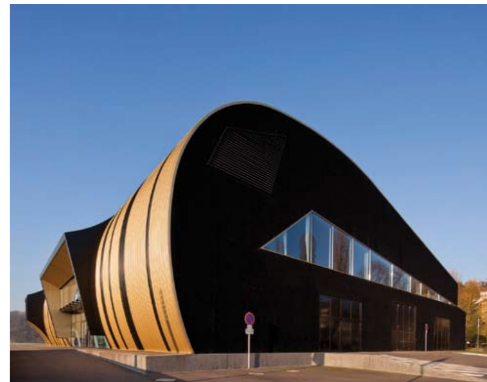
Rénovation du Hall Deich à Ettelbruck
