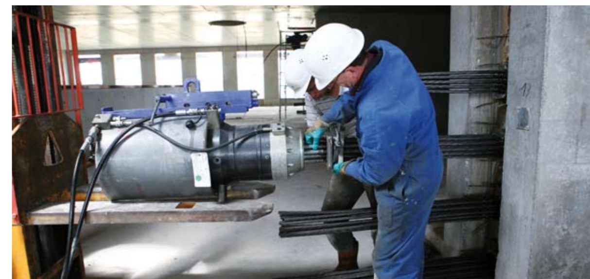
Mise en place des câbles servant à suspendre la barre
