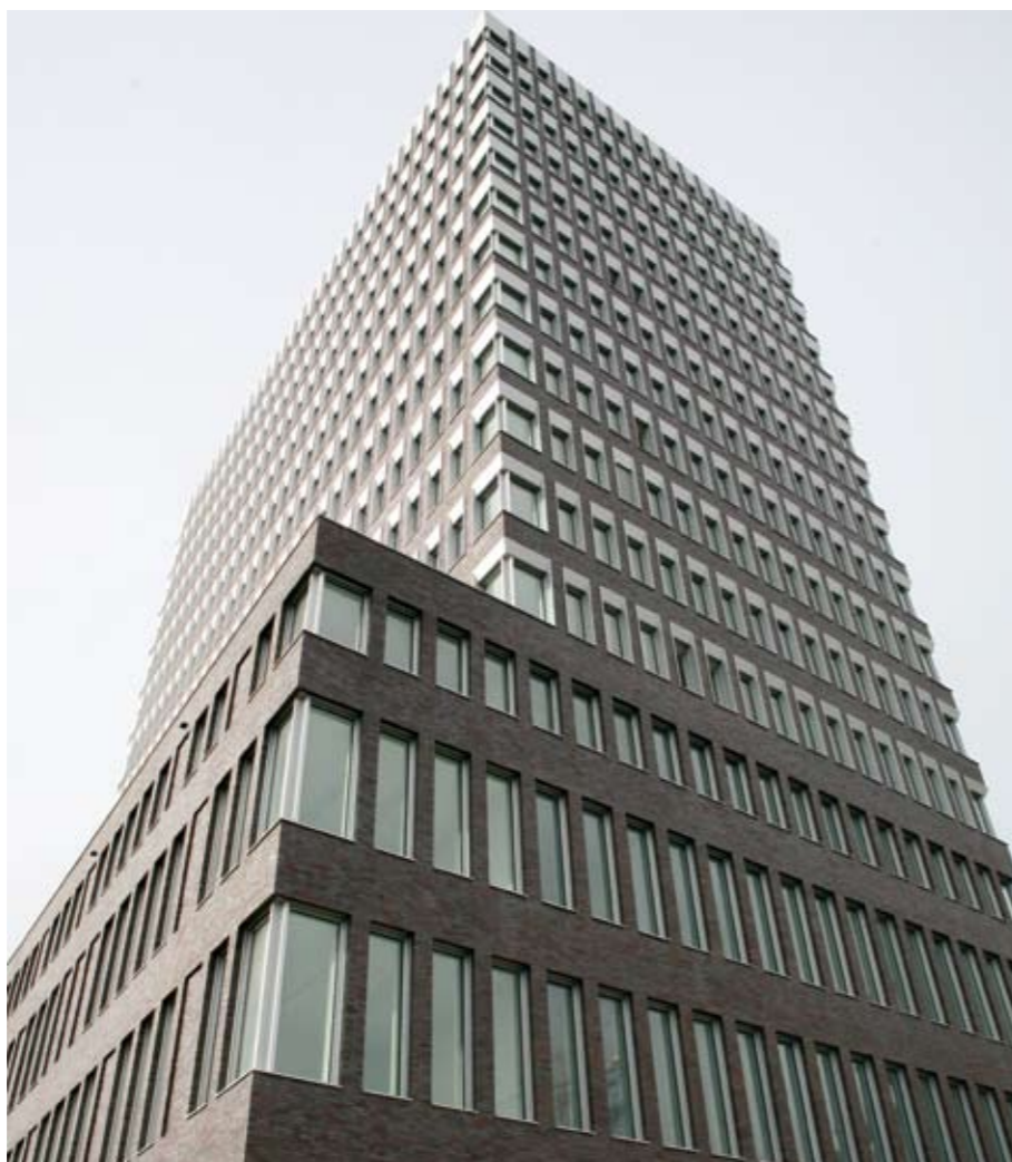
Le premier Bâtiment administratif de l'Etat à Belval
