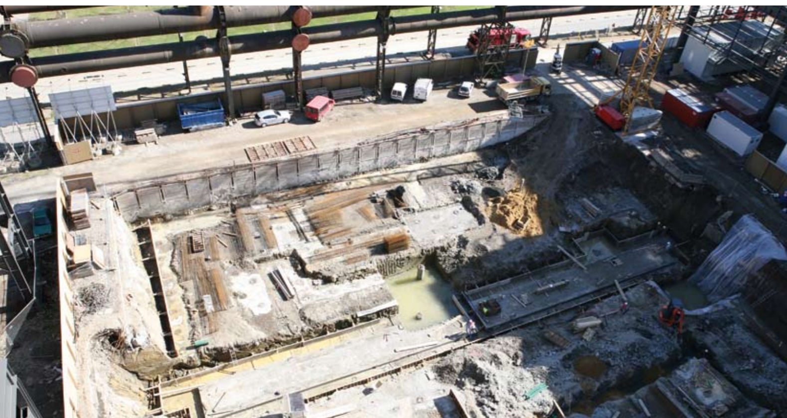
Vue sur les travaux des fondations
