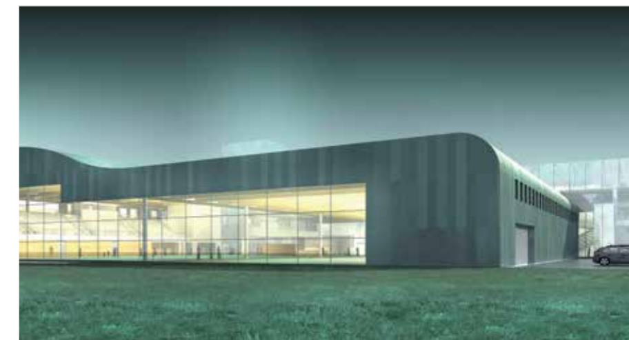
Façade du centre multisport
