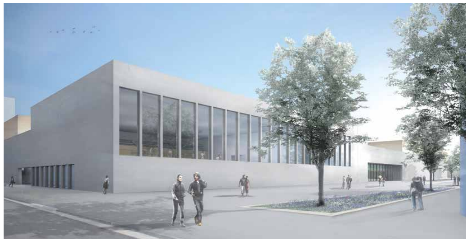
La façade Nord comportant l'entrée principale
