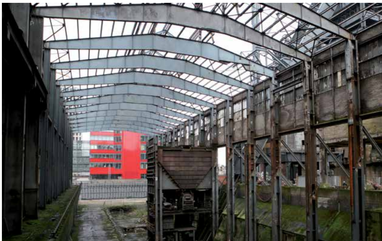
L'ossature de la Möllerei et le silo à minerai
