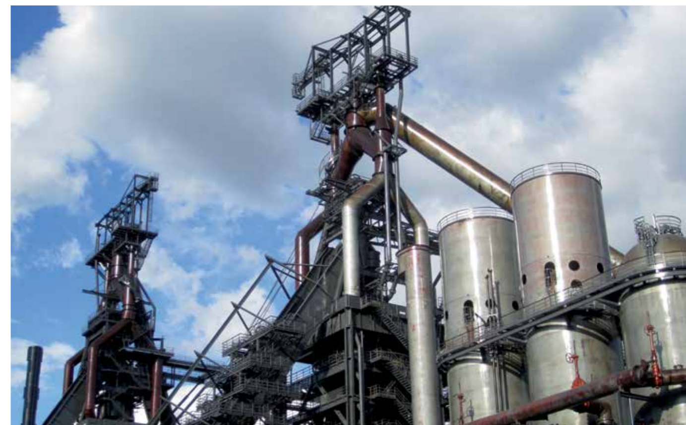
Mise en lumière, concerts et accès à la plateforme du gueulard à l'occasion de la première fête des hauts fourneaux à Belval
