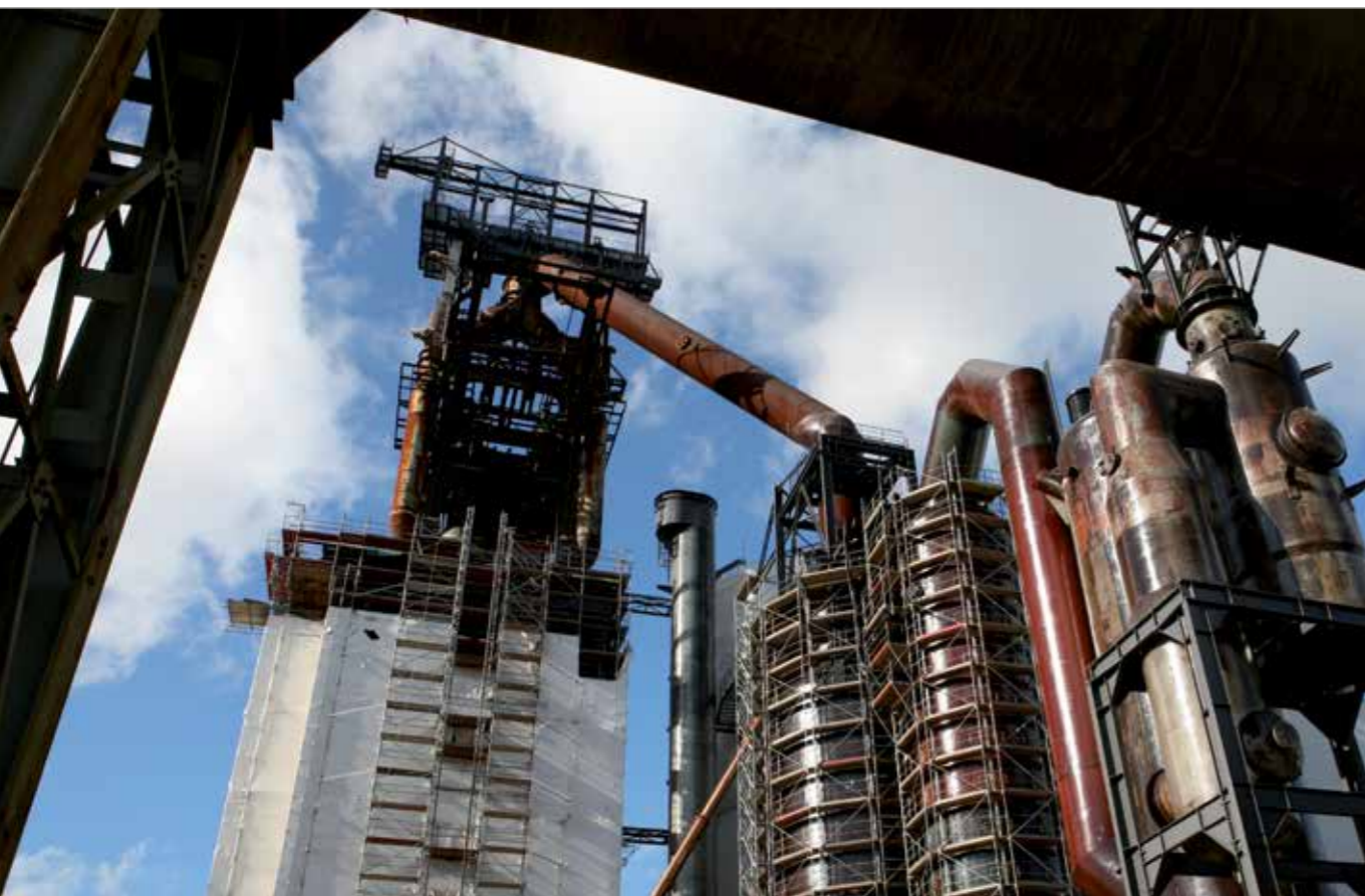
Les échafaudages sur les hauts fourneaux - un défi très particulier
