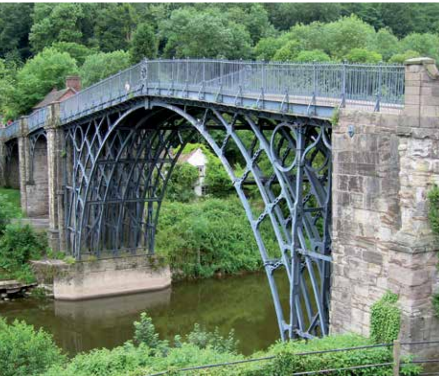
Le pont de Coalbrookdale en Angleterre (1779)
