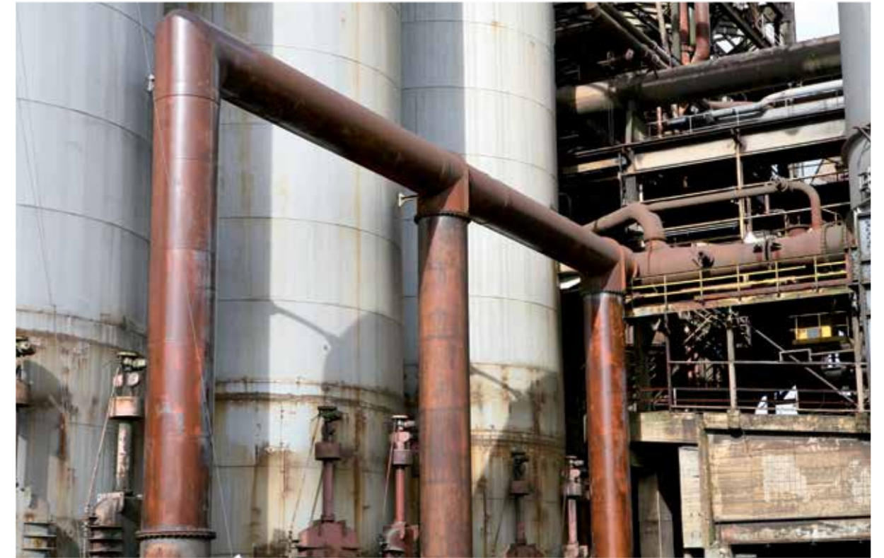
Une longue période d'essais a précédé la mise en oeuvre des traitements de surface
