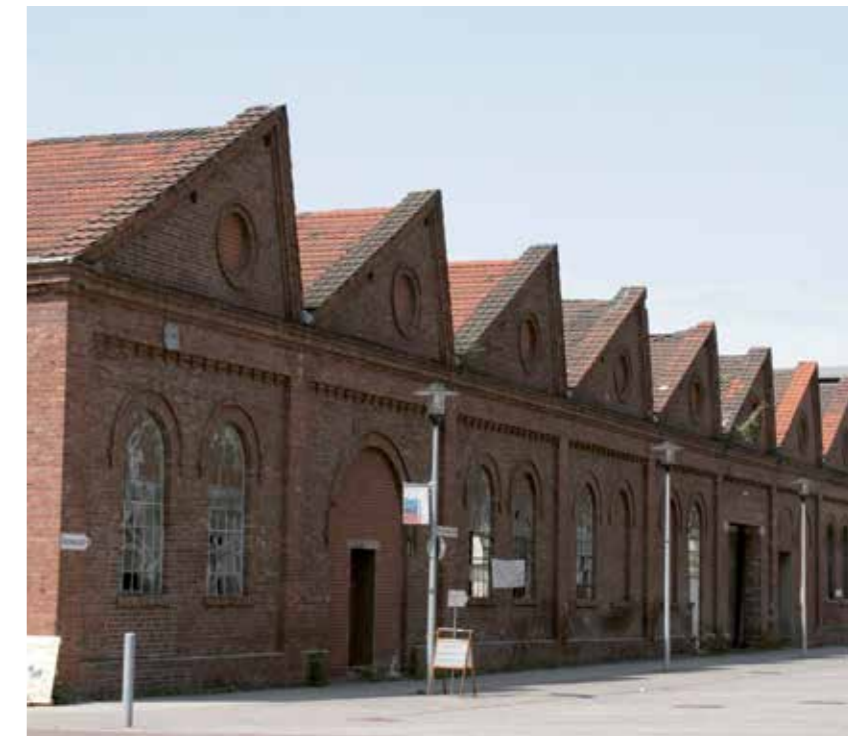
Bâtiment à toiture en dents de scie
