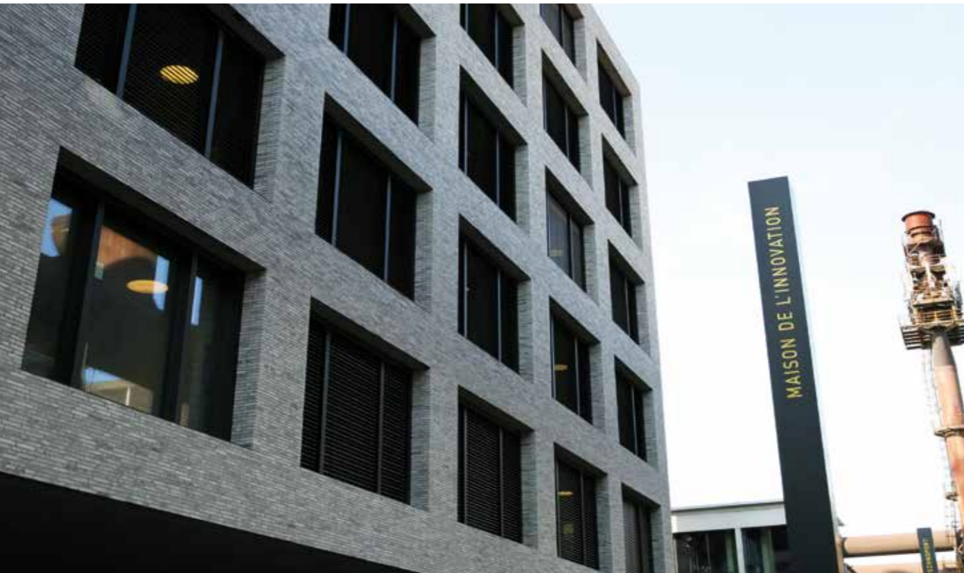
La Maison de l'Innovation, située au cœur des hauts fourneaux, héberge entre autres le LIST
