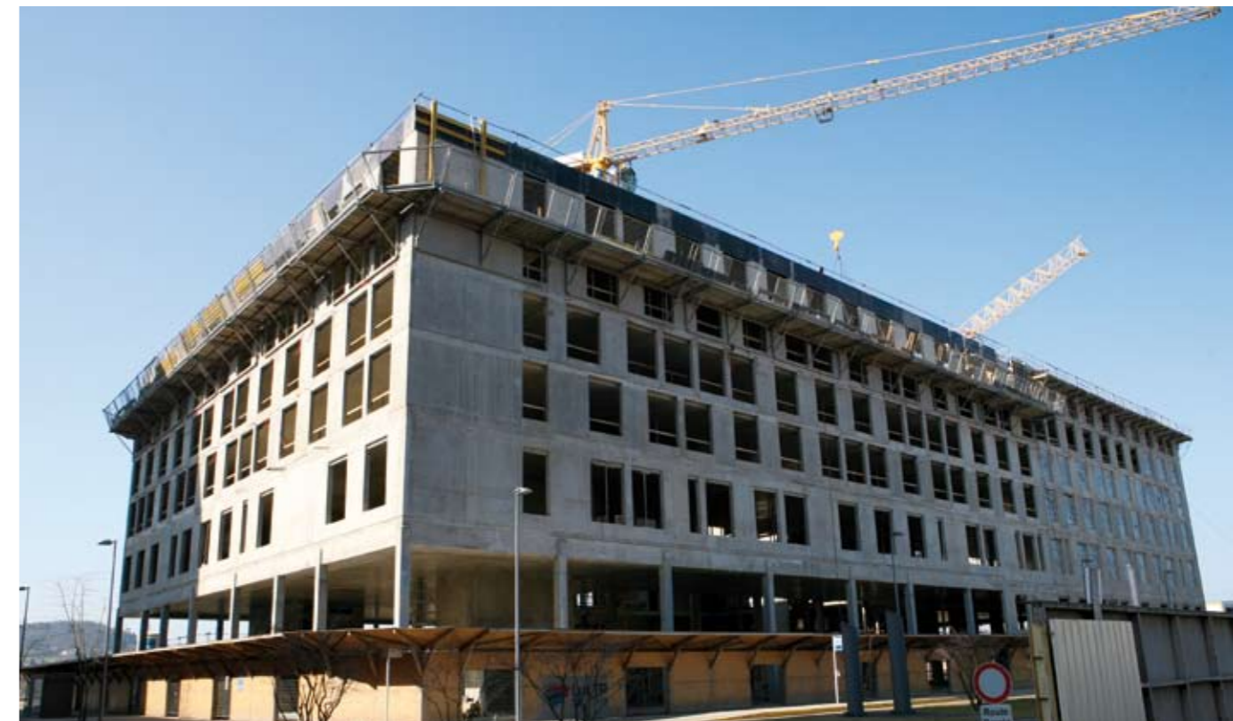
La Maison des Sciences Humaines, façade Sud-Est en mars 2012
