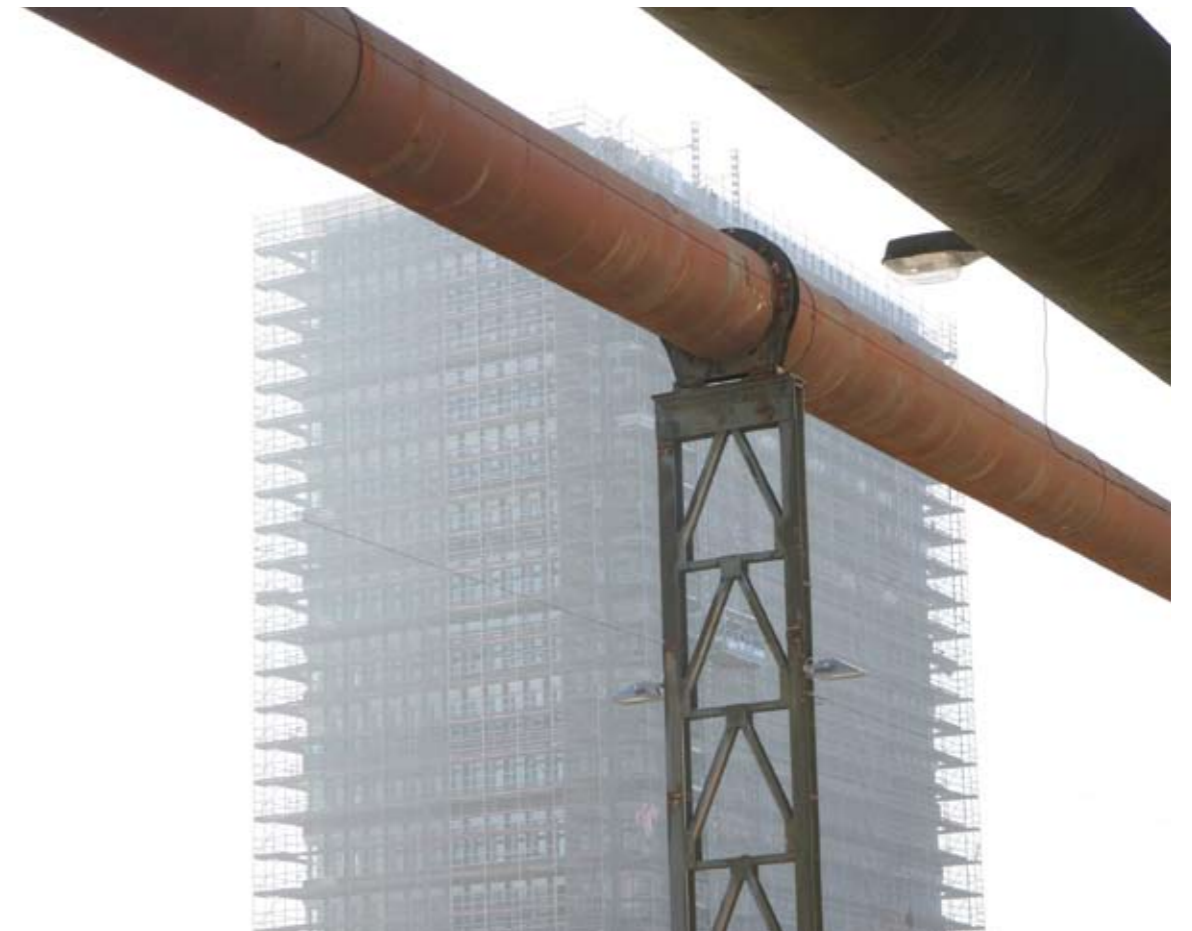
La tour du Bâtiment administratif, mise en place du revêtement de la façade
