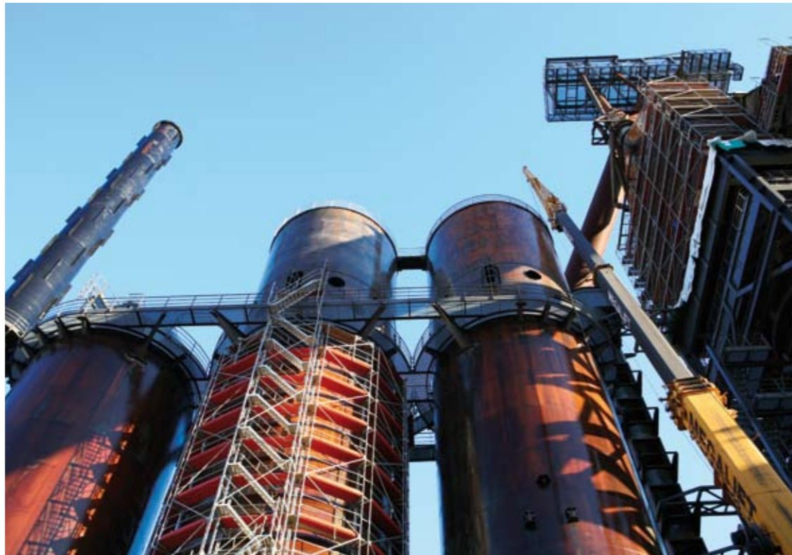
Achèvement du traitement des surfaces sur les cowpers du haut fourneau B
