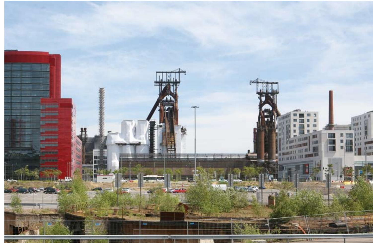
*Bâchage du haut fourneau B en vue des travaux de nettoyage et de traitement des surfaces*
