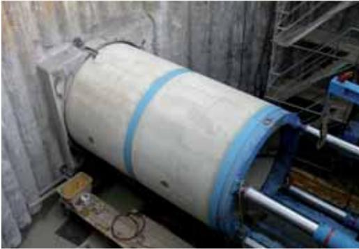
Forage de la galerie technique pour les lignes haute tension de Créos et de Sotel
